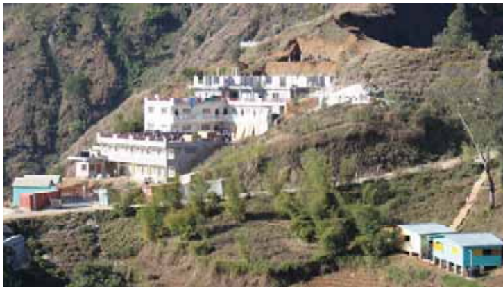
Overzichtsfoto van Ecole Soleil de Hollande in Ka-Blain Bovenaan het afgraven van de berg en de etage en babyhuis in aanbouw
