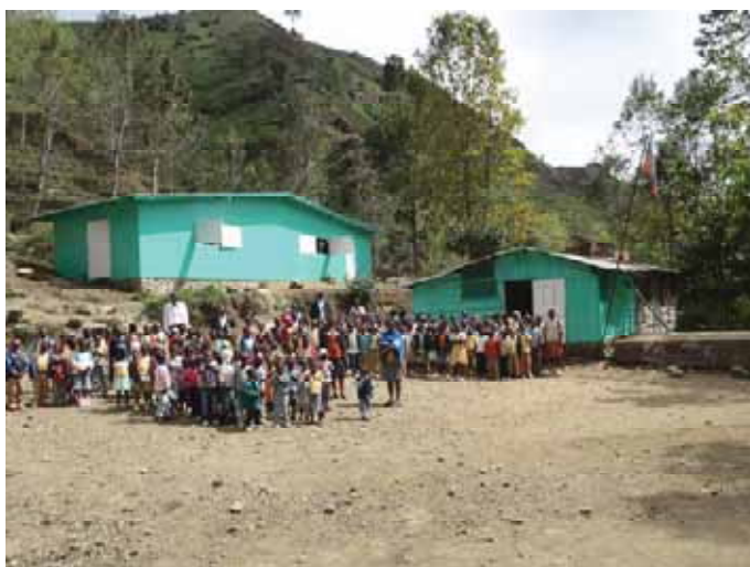
Links het nieuwe gebouw met twee klassen in Godinot
