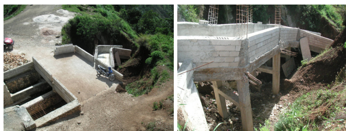
De brug boven het grote waterreservoir met rechts en links het kanaal.
