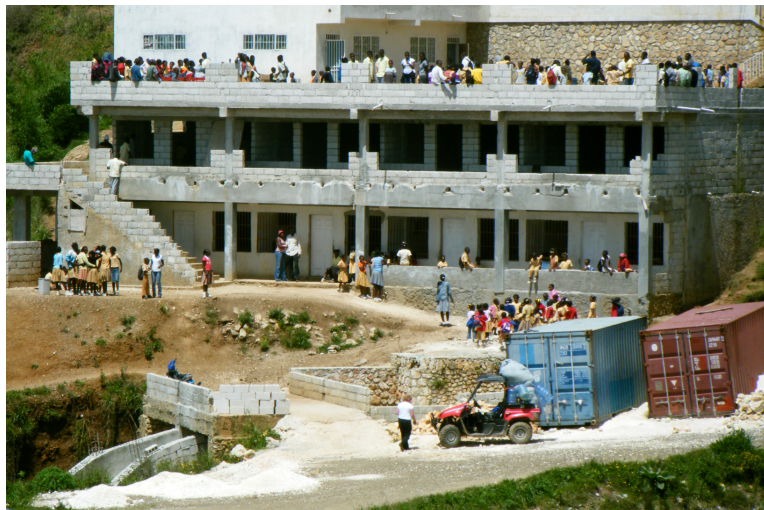
De lagere school, 2x 4 klaslokalen in Ka-Blain, is in september klaar. Ook ziet u links van de brug een stukje van het nieuwe kanaal.
