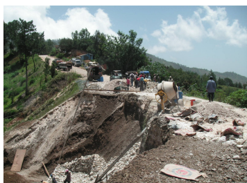
De reparatie aan de weg
