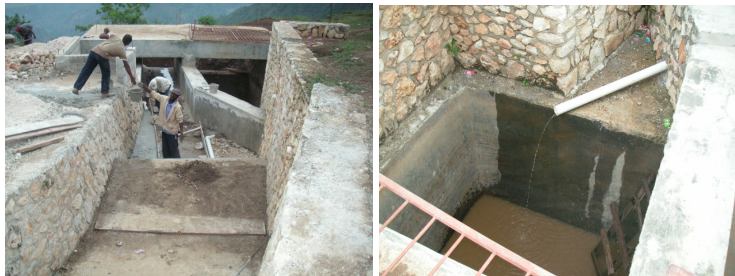
De kanalisering van het vuile regenwater en het bijna schone bassin.
