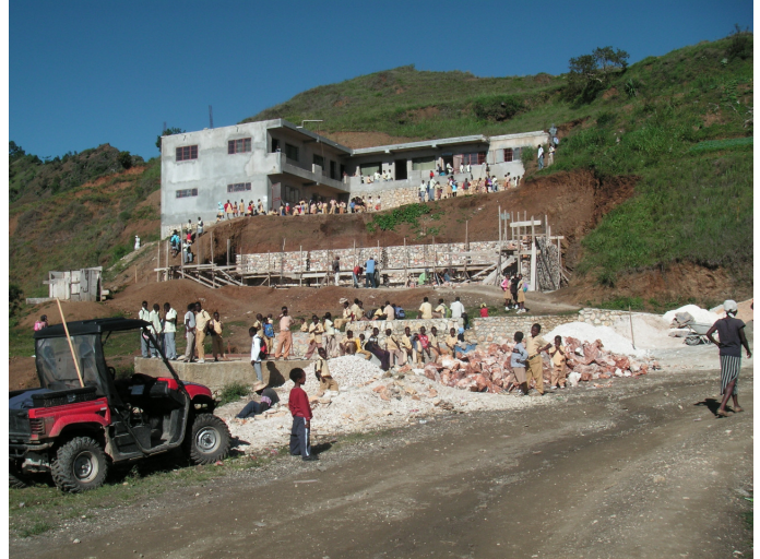
De kleuterschool en de bouw van de lagere school in Ka-Blain, 4 juni.
