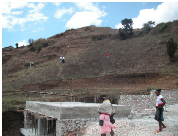
21 februari 2007, uitzetten bouwput.
