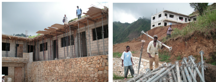
Een overzicht van de bouw tot 25 augustus 2007
