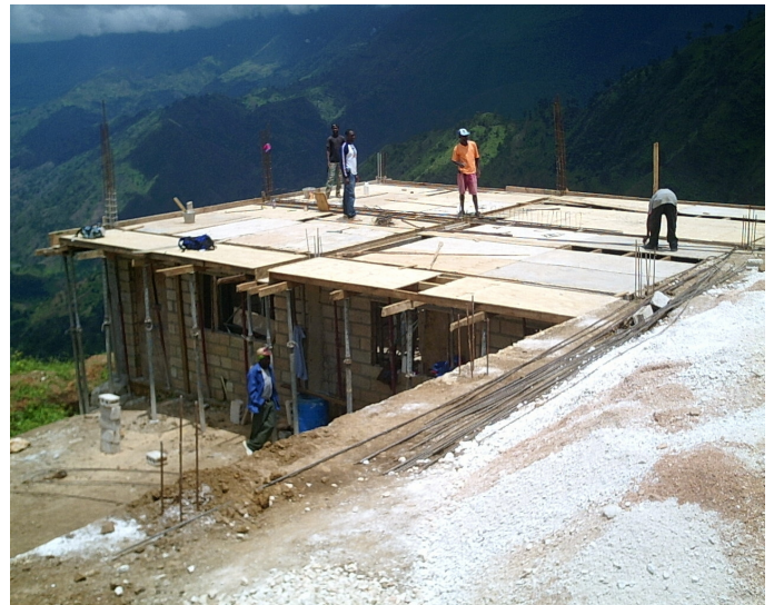
2 juni maakt men het betonijzer in vloer/plafond, 6 juni cement storten.
