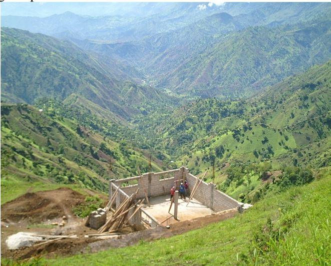
De uitgestrekte bergen rond Ka-Blain en de bouwplaats.
