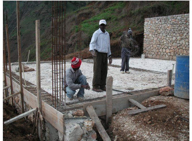
Fundering van 2 klassen van de bouw in Ka-Blain op 20 april 2007.
