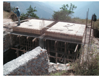
Bekisting voor de brug, 16-2-'07
