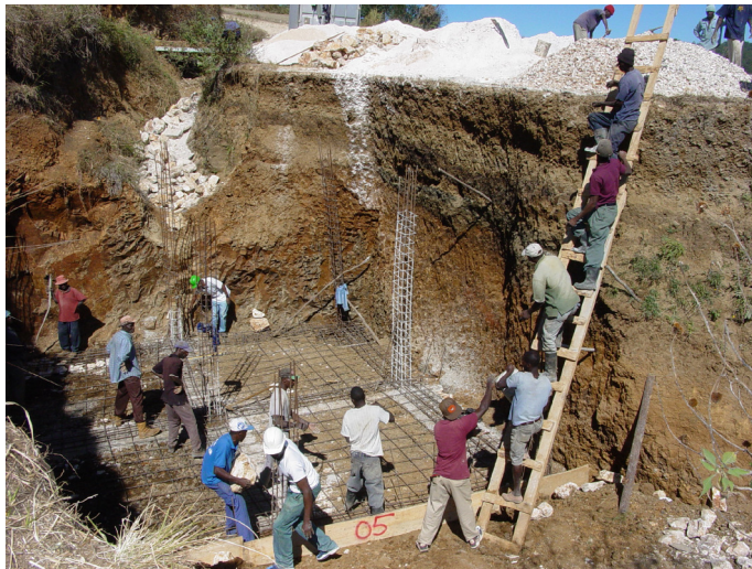
Het storten van de bodem van het waterbassin. Er was al een groot fundament in de grond gebouwd. 13-01-2007.
